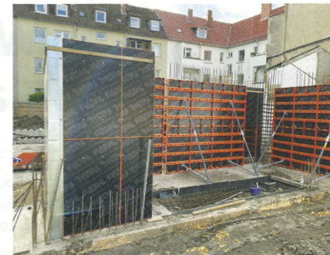
Das Multi-Element der Neo-R-Leichtschalung bietet dank der zusätzlichen Lochprofile vielfältige Einsatzmöglichkeiten. Fotos: Paschal
